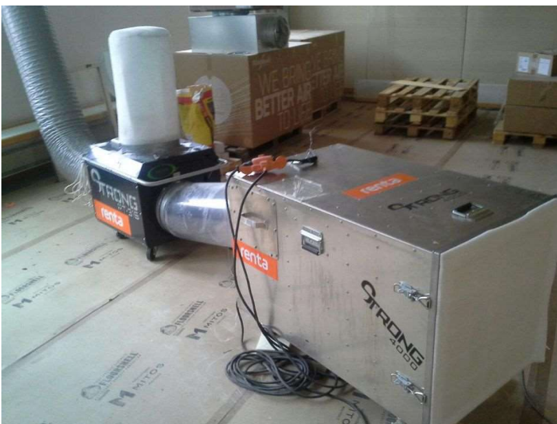
Kukin osastointialue kussakin kerroksessa varusteltiin APAD paineentasausjärjestelmällä.
